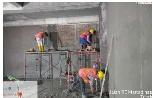
Pekerjaan Plesteran dan Acian
