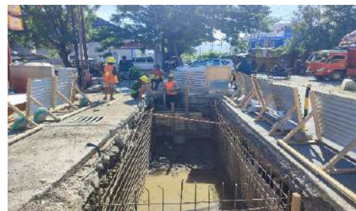
Pekerjaan Box Water Meter Induk DMA 1B
