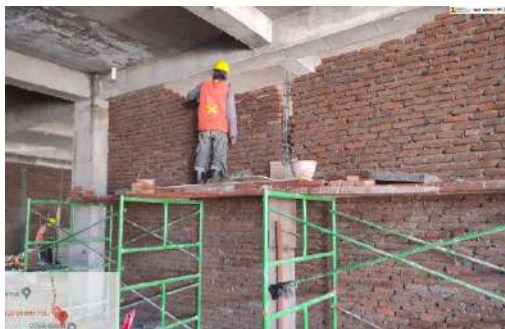
Pekerjaan Pasangan Dinding
