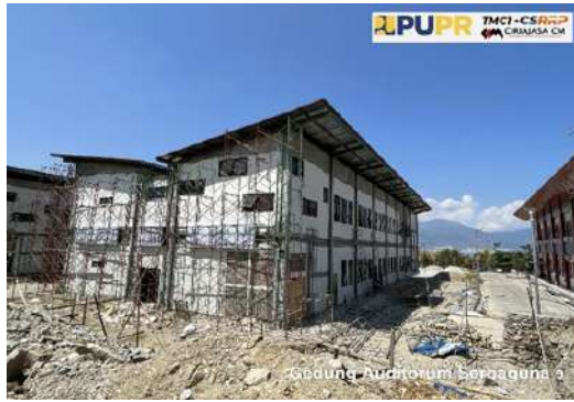
Progres Konstruksi Gd. Auditorium Serbaguna 9
