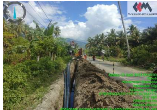
Pek. Galian pemasangan pipa HDPE 250 mm & 90 mm zona 1 (palu-bangga)
