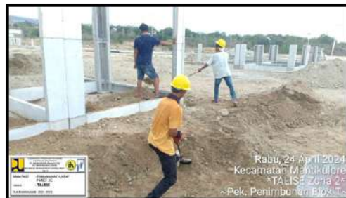
Pekerjaan Penimbunan bawah lantai
