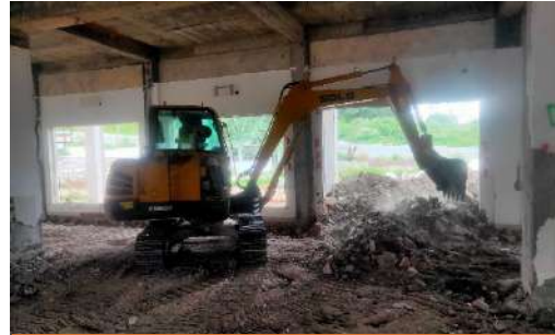
Kegiatan Pembongkaran Gedung
