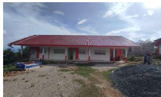
Progres Konstruksi SD Inp.2 Kawatuna
