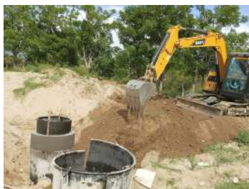
Pek. Pemasangan IC
