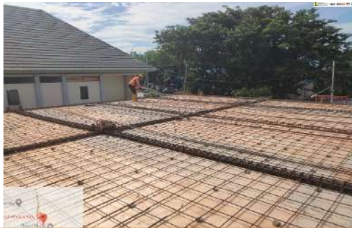
Pekerjaan Pembesian Lantai Roof Top
