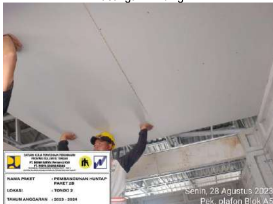
Pekerjaan Pemasangan Plafond
