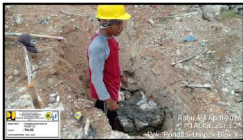
Pekerjaan Pengecoran Pondasi Umpak
