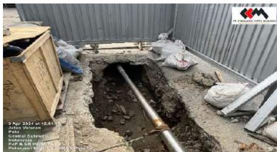
Pekerjaan HDD JDU DMA.6
