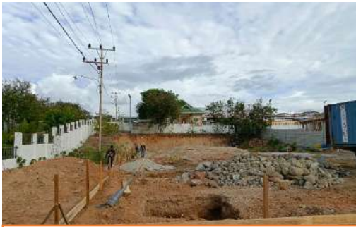
Pekerjaan Galian Pondasi G. Workshop
