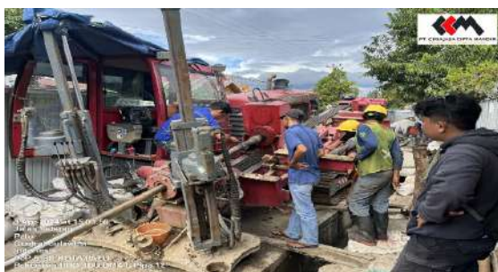
Pekerjaan HDD JDU DMA.6
