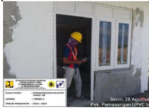
Pemasangan Jendela UPVC
