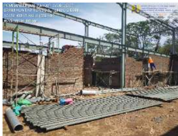
Pek. Erection Pipa Baja
