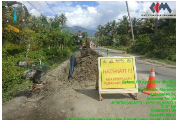
Pek. Galian pemasangan pipa HDPE 250 mm & 90 mm zona 1 (palu-bangga)
