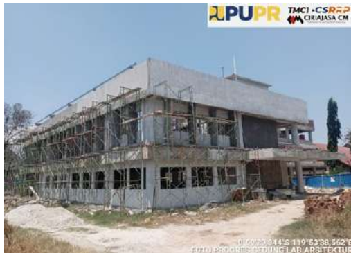
Progres Konstruksi Gd. Lab Arsitektur
