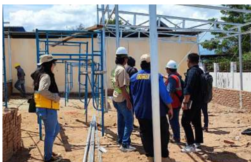
Pekerjaan Direksi Keet
