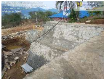
Pek. Pasangan Batu Talud
